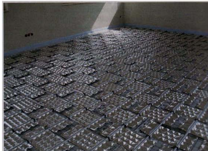
Die Oberflächenstruktur des Thermoleitblechs aus Aluminium mit Pyramidenprägung sorgt für eine Vergrößerung der Heizfläche.
