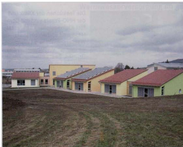
Der Neubau einer Schulvorbereitenden Einrichtung wird mit einer Solarthermie-Anlage und Wärmepumpen beheizt.
